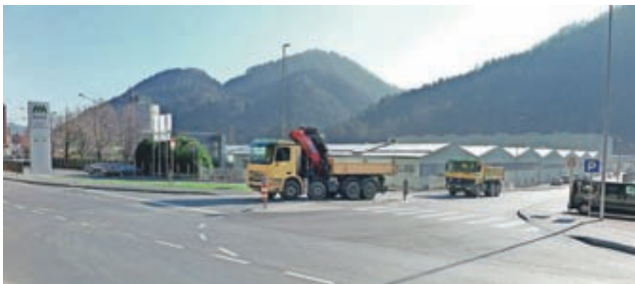
V Poslovni coni Alples so preuredili slabo pregledno križišče ob uvozu v cono in obnovili več odsekov vodovoda.
