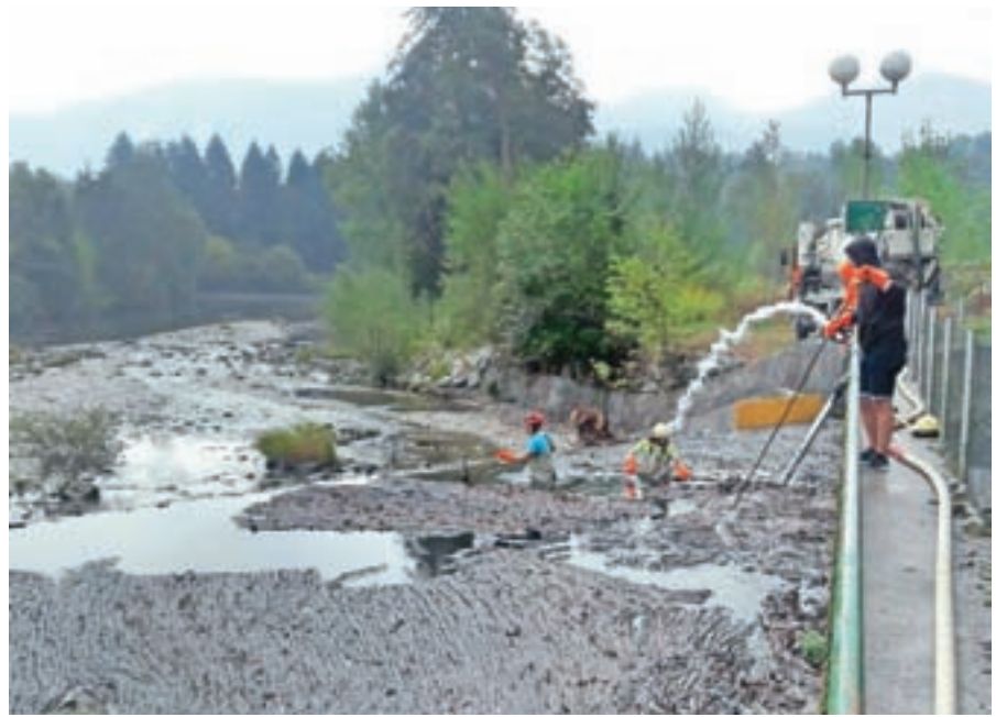
Smrdeče naplavine iz Save so odpeljali v kranjsko čistilno napravo.
