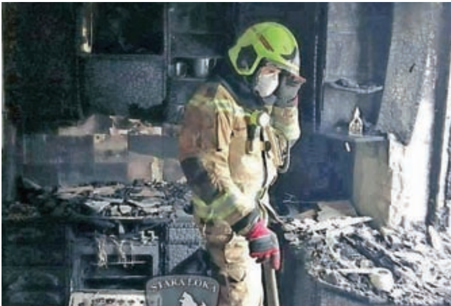
Zaradi požara uničena garsonjera v Groharjevem naselju v Škofji Loki
