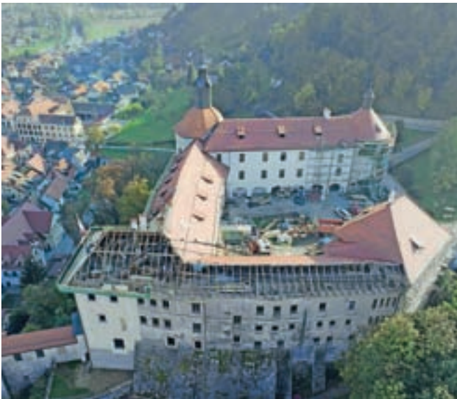
Med obnovo strehe Loškega gradu
